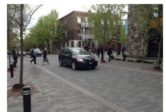
Intersection surélevée - rue Laurier
